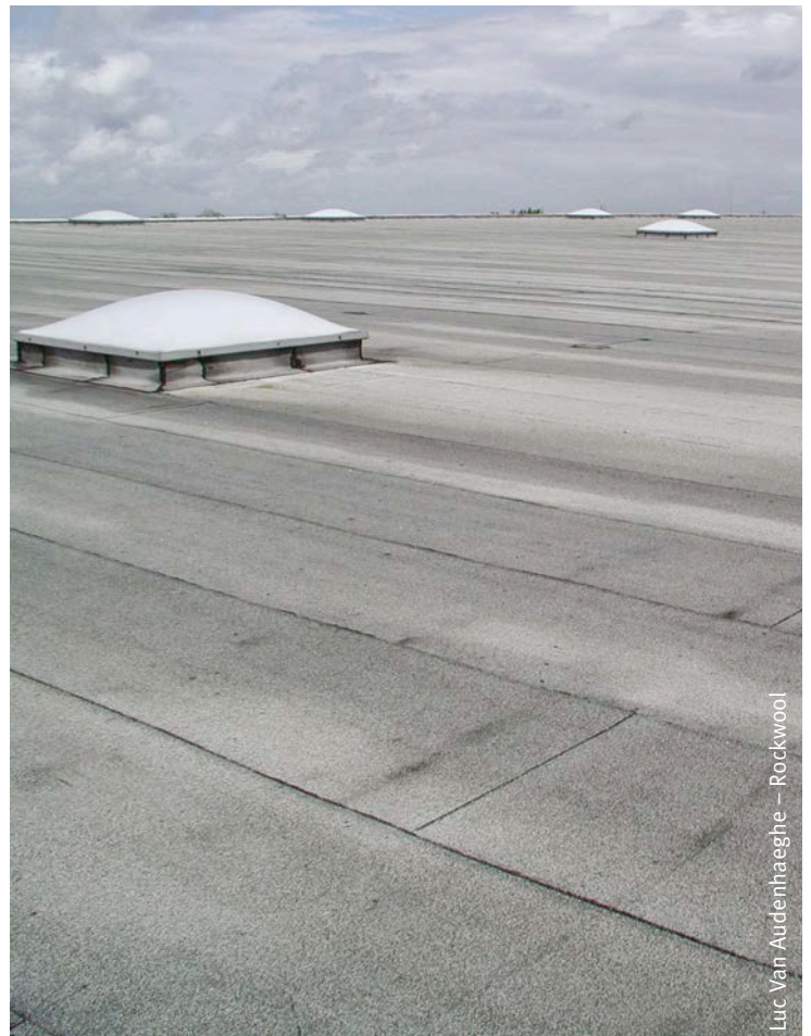
Afb. 68 Dak dat voorzien is van een bitumineuze afdichting.
