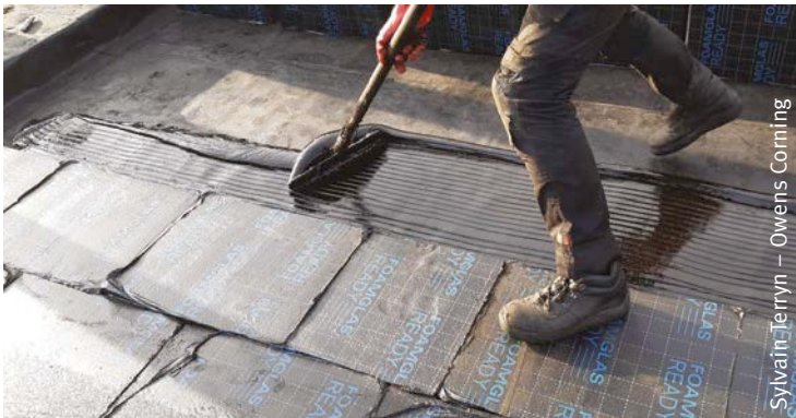
Afb. 64 Toepassing van een bitumineuze koudlijm.
