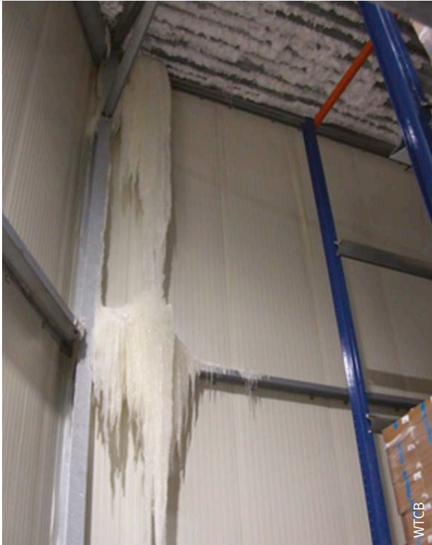
Afb. 36 Omvorming van condensatie tot ijs ten gevolge van een luchtlek in een koelruimte.
