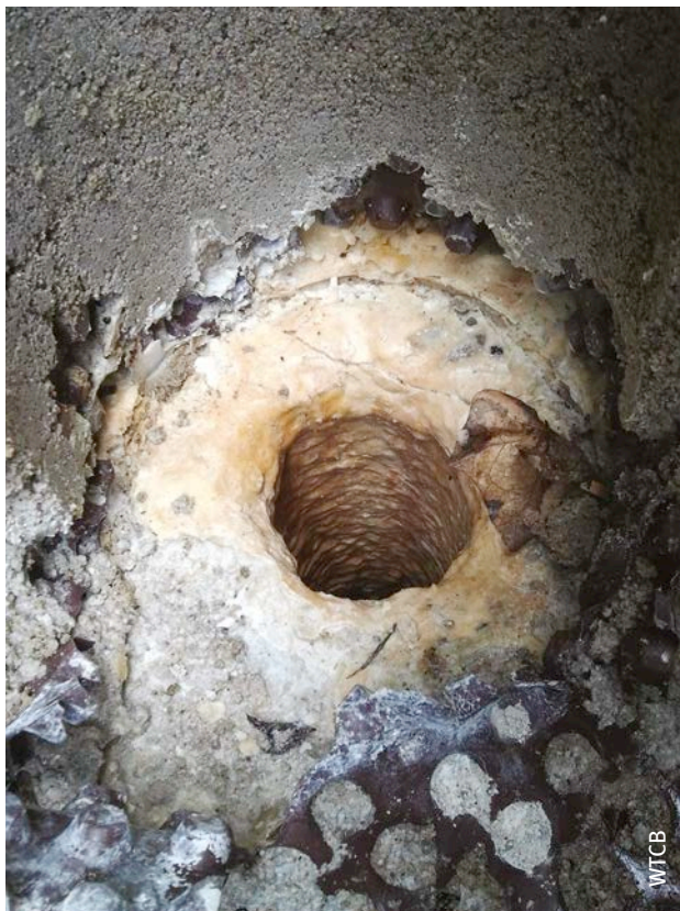
Afb. 93 Verstopping van een kolk door kalk, afkomstig van de stelmortel van de tegels.
