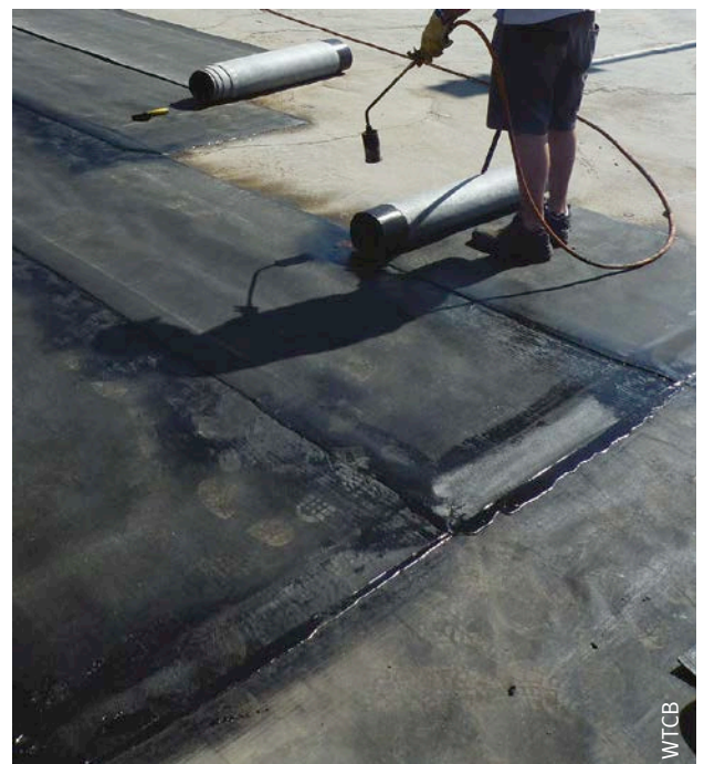
STAP 2 – DWARSNAAD TUSSEN DAKBAAN 'B' EN DAKBAAN 'C'; LANGSNAAD TUSSEN DAKBAAN 'C' EN DAKBAAN 'A'
