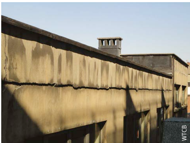
Afb. 25 Uiterste temperaturen op een dak dat voorzien is van isolatie onder de dakvloer.
