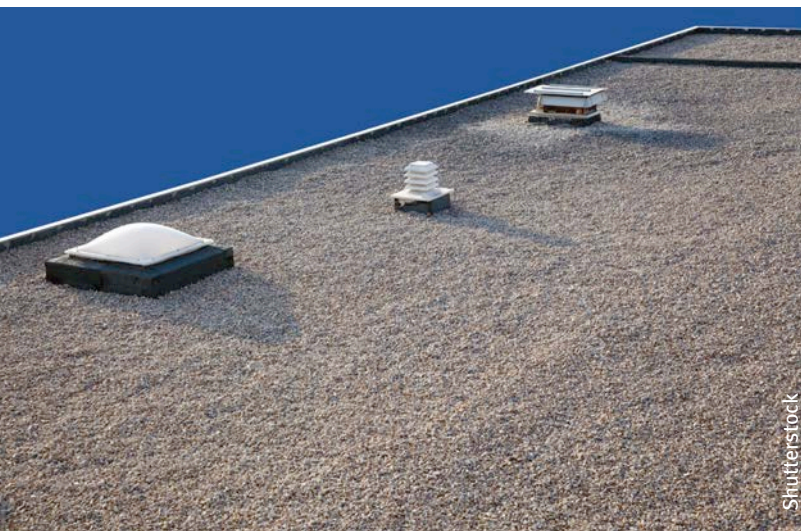
Afb. 91 Dak dat bedekt is met rolgrind.
