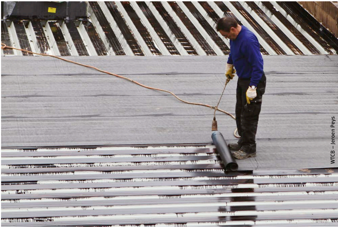
Afb. 56 Plaatsing van een bitumineus dampscherm op een dakvloer uit geprofileerde staalplaten.
