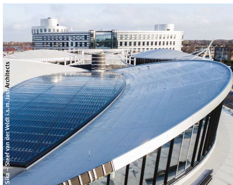
Afb. 83 FPO-afdichting.
