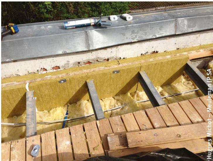
Afb. 97 Opening van de uitstekende dakrand met het oog op het isoleren ervan.
