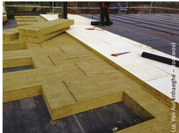
Afb. 62 Plaatsing van platen uit minerale wol.
